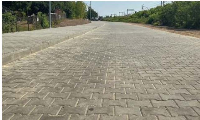
Przebudowana jezdnia i chodnik na ul. Mostowej
