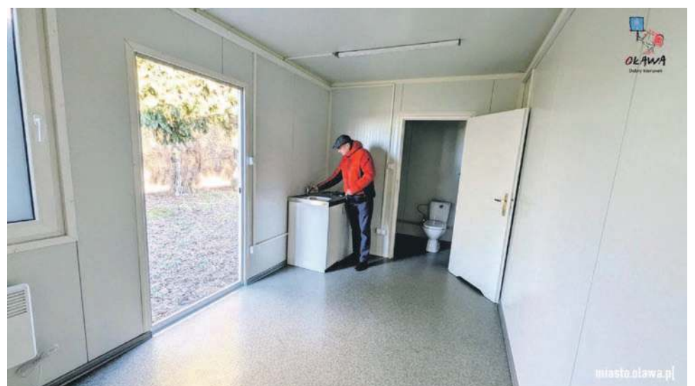
Kontenery mają węzeł sanitarny i ogrzewanie
