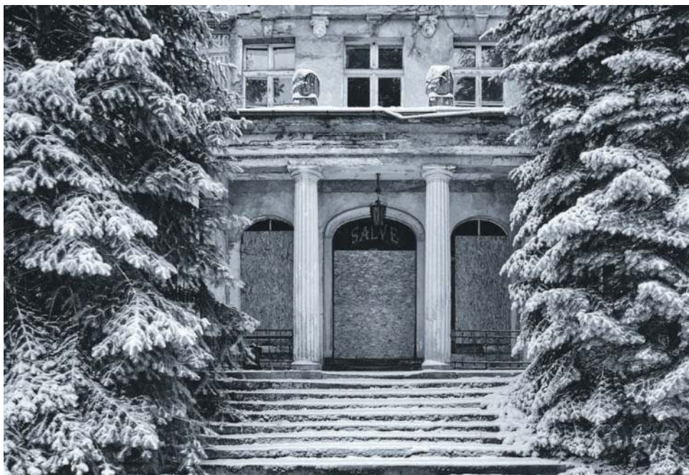
Pałac w Jelczu-Laskowicach przy ul. Kukulczej
