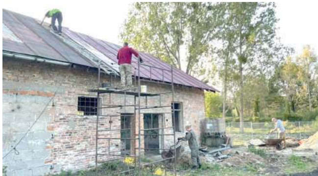
Trwają prace przy adaptacji na cele bazy Combat Alert budynku po dawnej wytwórni oranżady
