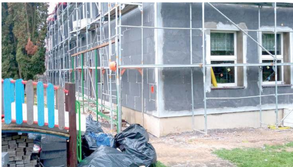
Prace idą pełną parą. Wszystko odbywa się z wykorzystaniem styropianu o grubości 16 cm
