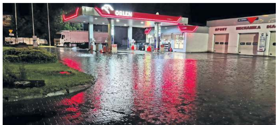
Zalany został także plac na stacji paliw Orlen na ul. Zabkowickiej. (Foto: Strzelin998)
