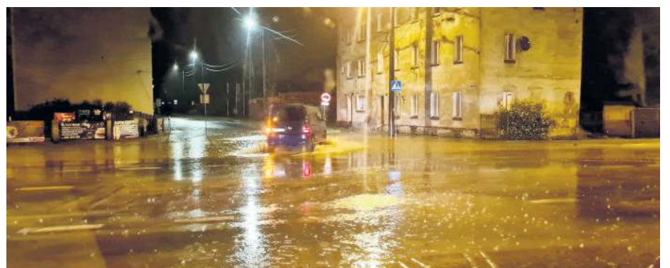
Stałym miejscem, w którym dochodzi do zalewania, jest skrzyżowanie ul. Staromiejskiej z ul. Wojska Polskiego. (Foto: Strzelin998)
