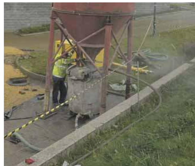
Wymieszane z wodą popioły są wtlaczane do podziemnej pustki ZDJĘCIA: JAROSŁAW MYŚLIŃSKI
