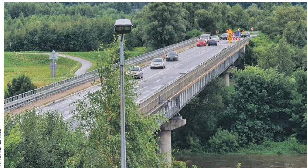
Widok na most w Jankowicach
