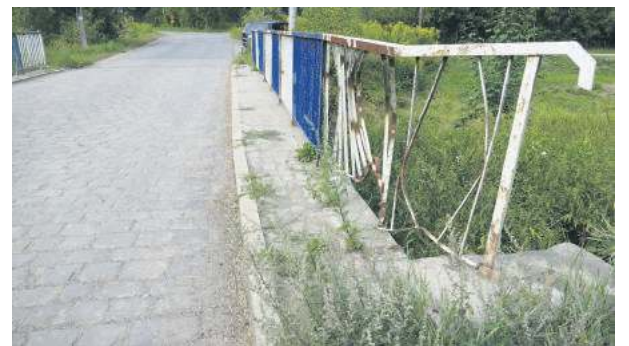
Już niebawem barierki na mostku na Krynce w Przewornie zyskają nowy blask i kolor
