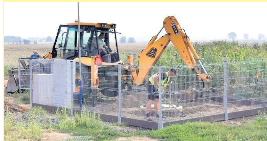
Inwestycja rozpoczęła się w ubiegłym roku, a wartość robót budowlanych to ponad 4,8 mln zł (Foto: UMIG Strzelin)
