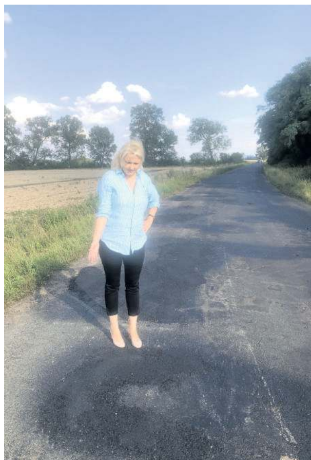
O remont odcinka Kondratowice-Białobrzezie od początku kadencji zabiegała radna powiatowa Ewelina Andrzejewska-Bochnak
