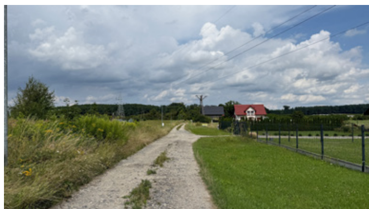
Powstanie kolejna droga dojazdowa do gruntów rolnych. Tym razem w Żerkowie.
