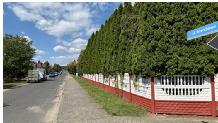
Ulica Wierzbowa przed przebudową. Obecnie trwają tu prace.
