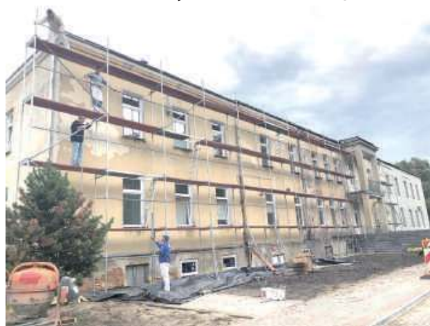
Ekipa budowlana pracująca przy remoncie oddziału zakaźnego szpitala w Biłgoraju, który od lat „straszył” pacjentów
