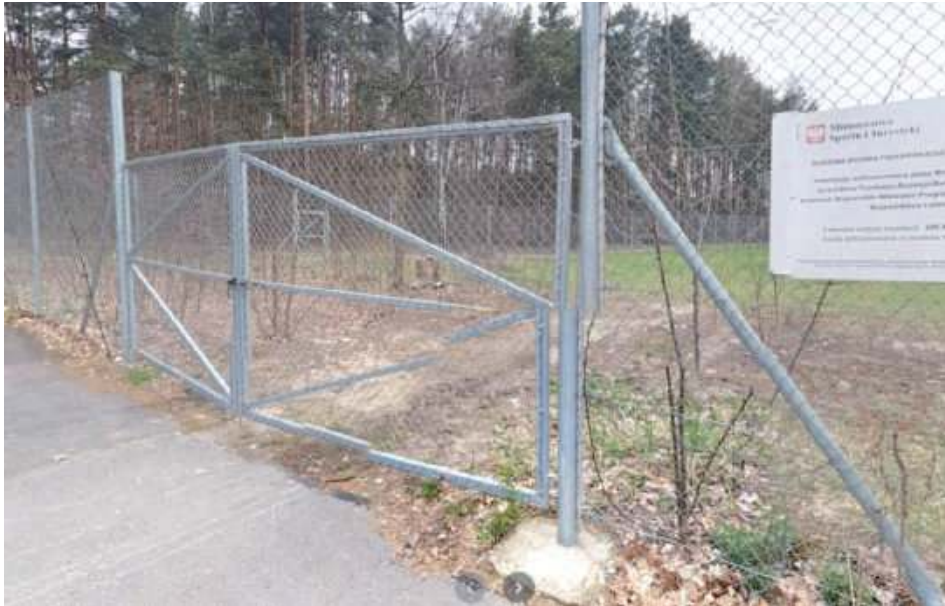
W budowie jest boisko ze sztuczną nawierzchnią w Majdanie Starym
