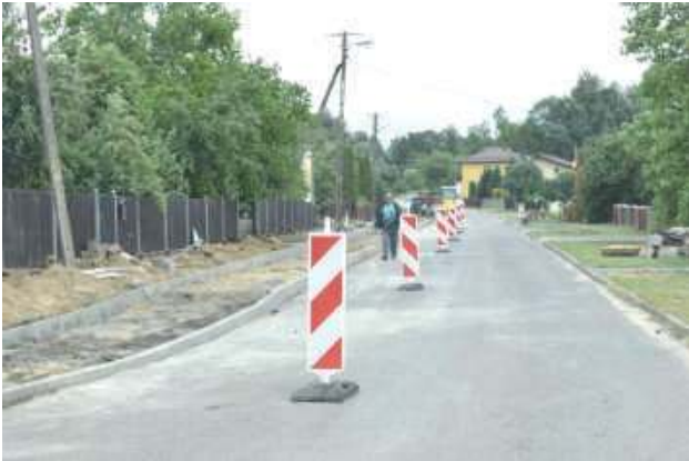
Rozpoczęła się budowa chodnika w ciągu ulicy Nadrzecznej w Księżpolu
