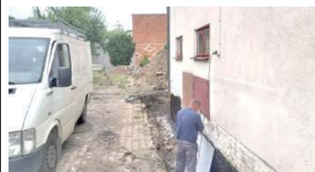
Przy ul. Radzieckiej 8 we Frampolu trwają roboty budowlane
