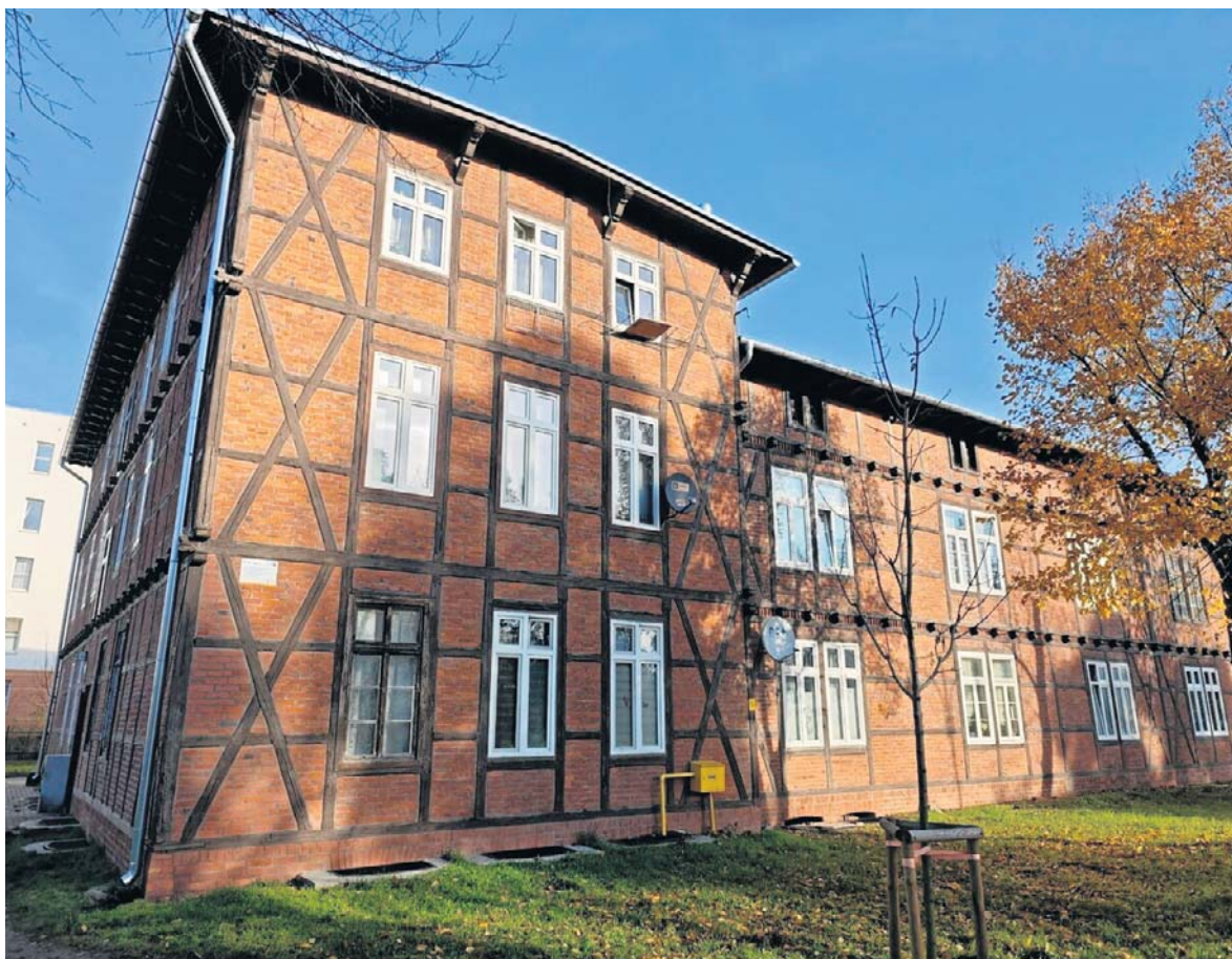
Same dawne koszały w Toruniu zostały wyremontowane kosztem 5,2 mln zł dzięki unijnemu wsparciu. Niestety, ta modernizacja klatek schodowych nie obejmowała...
