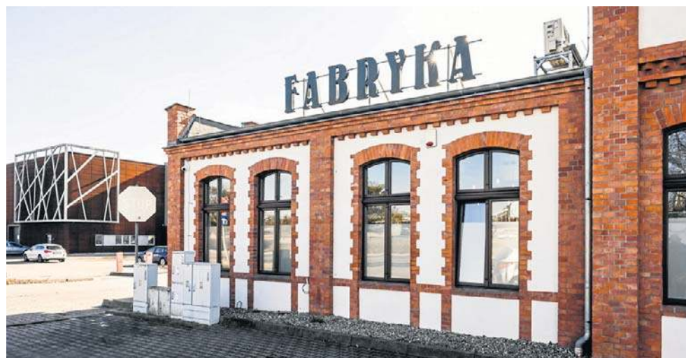
Najwyższa dotacja trafiła na odbudowę Fabryki Lloyd'a
