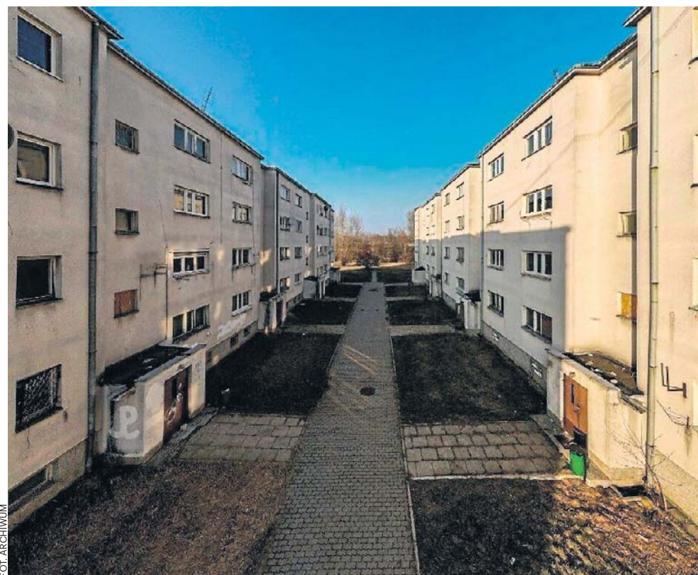
Koniec osiedla przy Dudziarskiej na Pradze coraz bliżej
