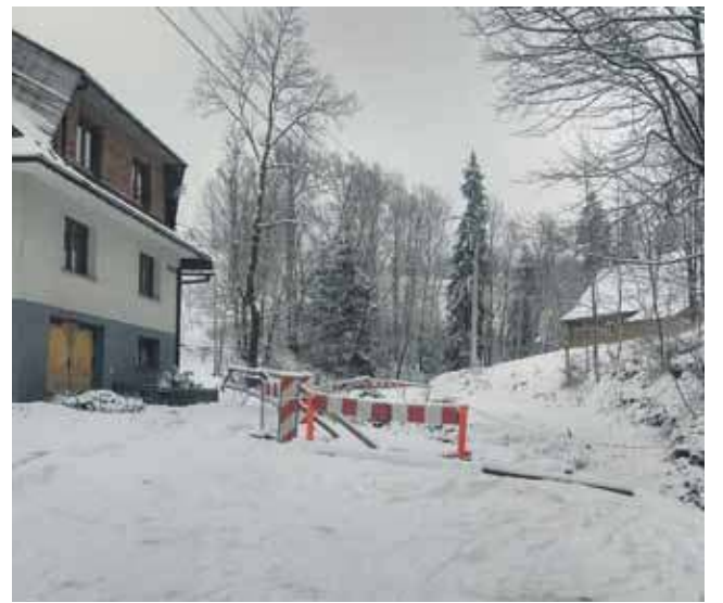
Z powodu remontu mostu 18 domów w Gliczarów Dolnym zostało odciętych od świata.
