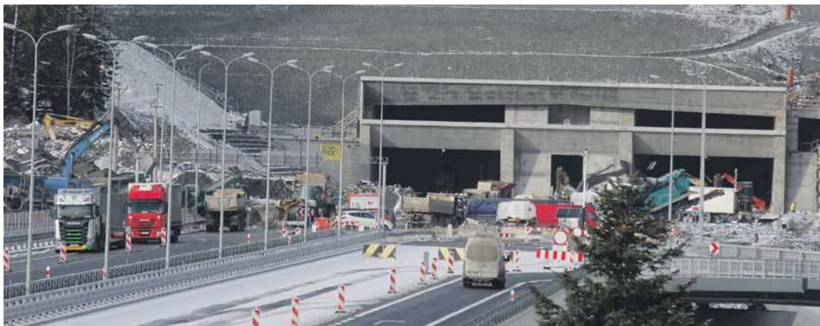
Południowy wlot do tunelu pod Małym Luboniem.
