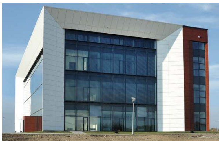
Budynek Logistyczny Elbląskiego Parku Naukowo Technologicznego
