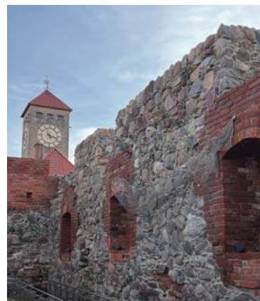
Zabezpieczenie Ruin Zamku Krzyżackiego w Szczytnie
