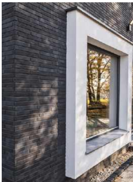
🔵 🟡 Płytki mineralne są cienkie, giętkie i znacznie lżejsze od tradycyjnego klinkieru, dlatego dobrze sprawdzają się na ocieplonych ścianach, również na systemach ze styropianem lub wełną mineralną. ELASTYCZNY KLINKIER / ELASTOLITH, ELKAMINO DOM
