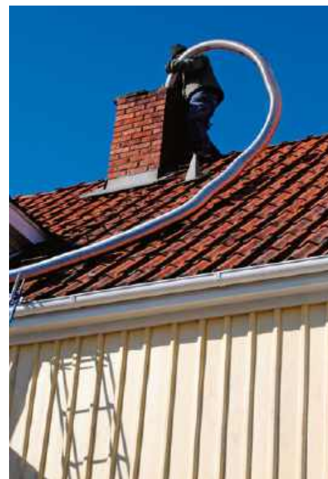
📍 Wymiana kotła bardzo często oznacza również konieczność wyposażenia komina w wkład. ADOBE STOCK
