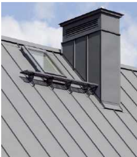
🔧 Detale wykończeniowe i obróbki najczęściej decydują o bezproblemowej eksploatacji dachu. BMI BRAAS, RUUKKI
