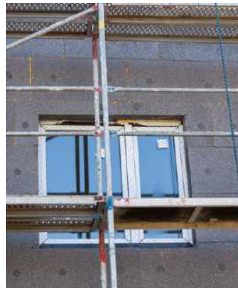
❷ Grafitowego styropianu nie wolno wystawiać na bezpośrednie działanie słońca. PSPS (POLSKIE STOWARZYSZENIE PRODUCENTÓW STYROPIANU)
