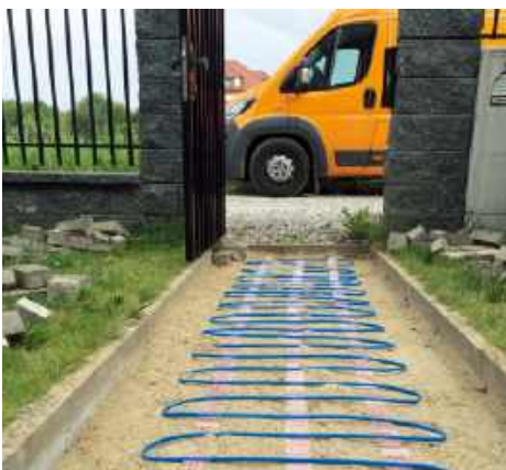
❶ Na ścieżce prowadzącej do domu przewody grzejne układa się na całej szerokości. RAYCHEM
