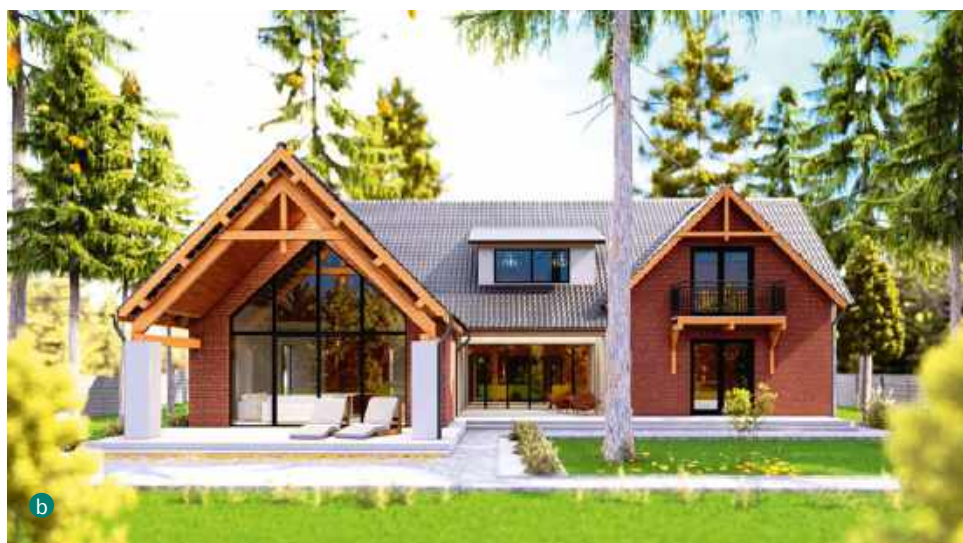
📍 Dom szkieletowy może być z zewnątrz nie do odróżnienia od tradycyjnego murowanego (a). Może mieć także widoczne drewniane elementy łączące się jednak z murowaną elewacją (b).
