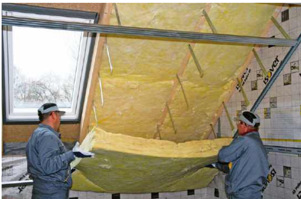
🔗 Najgrubszą warstwę ocieplenia, 20–30 cm, układa się w dachach. ISOVER
