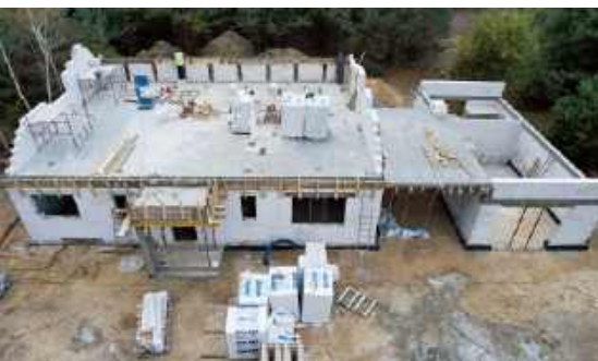
🔧 Jak tylko beton na stropie zwiąże, można przystąpić do wykonywania ścian nośnych następnej kondygnacji. T. RYBARCZYK
