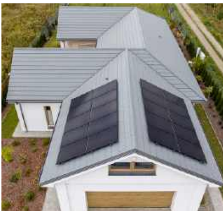
Dach pokryty dachówką betonową w jasnym szarym kolorze. swissporton
