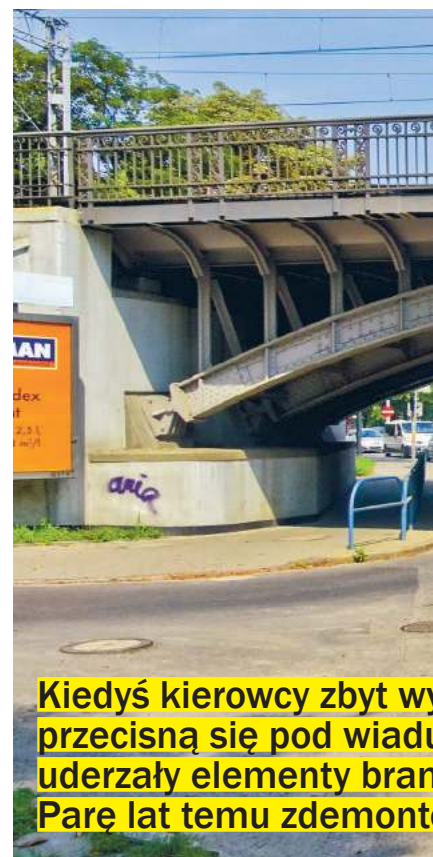
Wiadukt pod torami kolejowymi na al. Józefa Hallera
