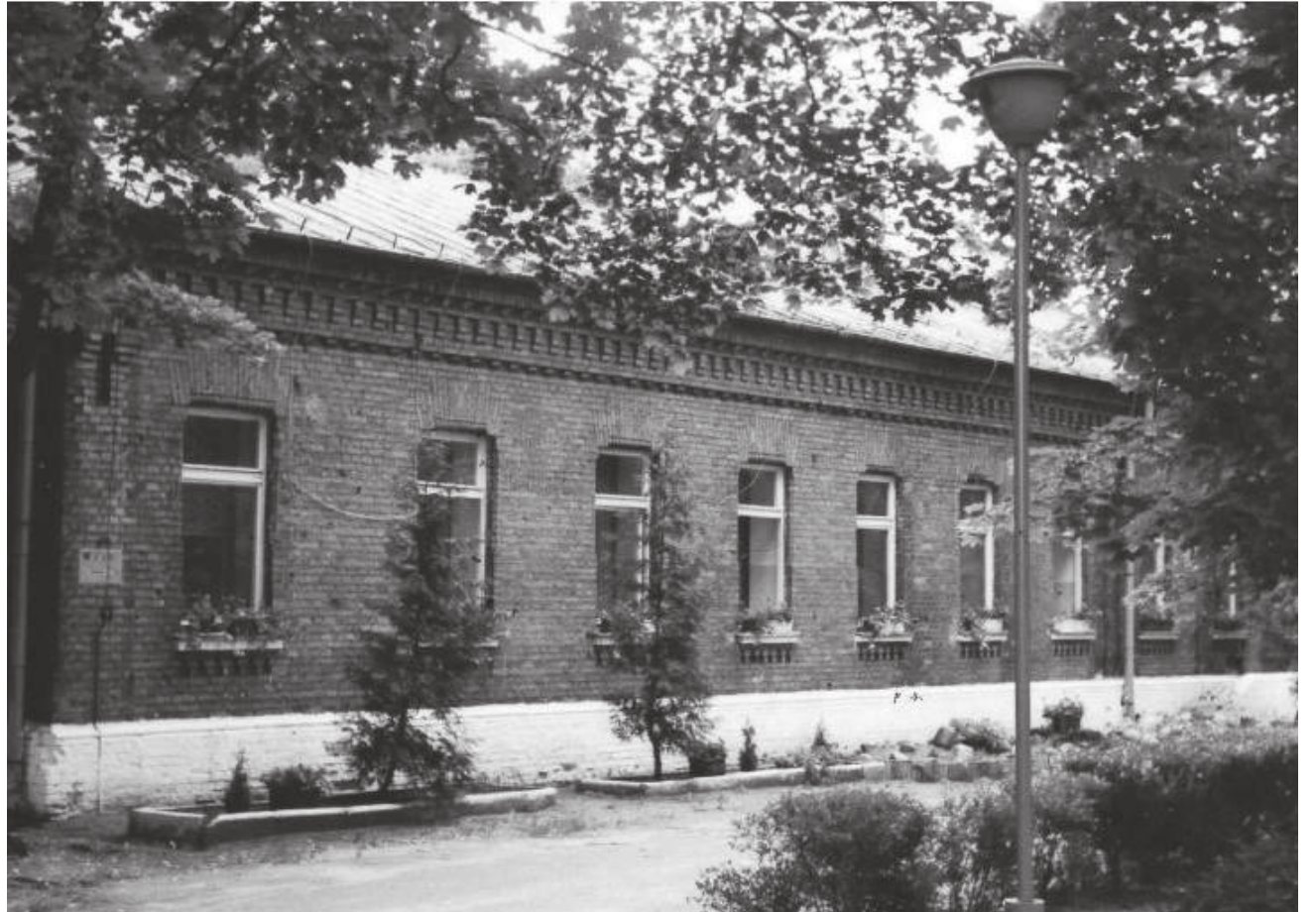
Budynek dawnych koszar rosyjskich, w którym od 1918 r. mieścił się szpital sejmikowy, a następnie powiatowy. Po przeniesieniu szpitala do nowego budynku pozostał tu oddział zakaźny. Od 2000 r. jest tu dom opieki
