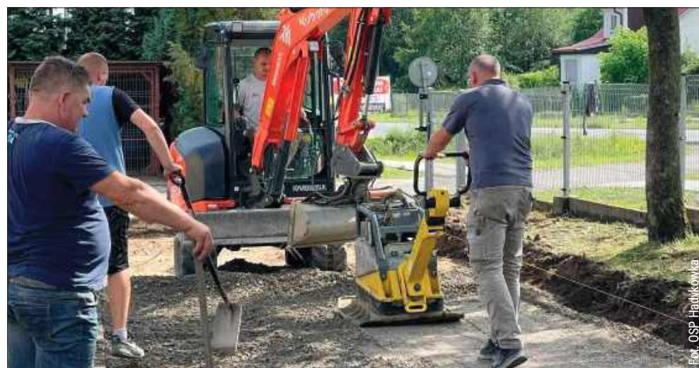
Druhowie z Hadykówki postanowili sami wykonać prace.
