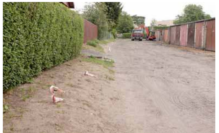
Po lewej słupki wyznaczające miejsce, gdzie powstanie chodnik, dalej prace ziemne przygotowujące do budowy właściwej nawierzchni drogi
