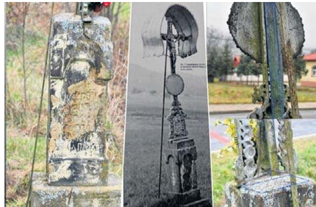
Prace przy renowacji krzyża wyceniono na 35 tys. zł. Roboty mają zakończyć się do 10 października tego roku
