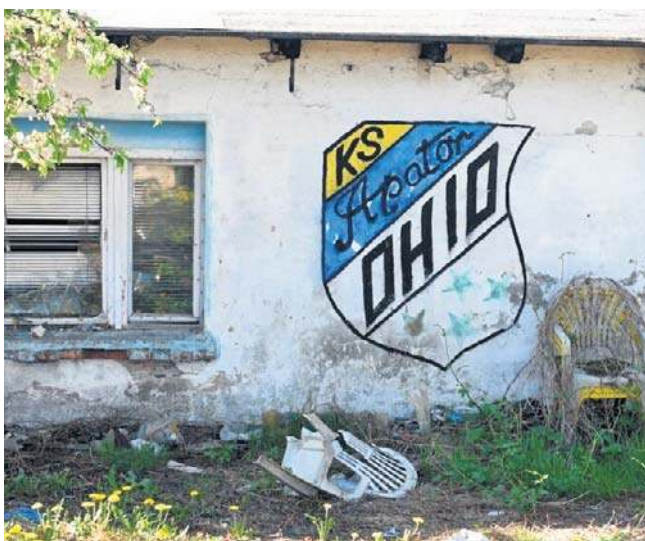
Czas wyburzeń w „Ohio” - rok 2021
