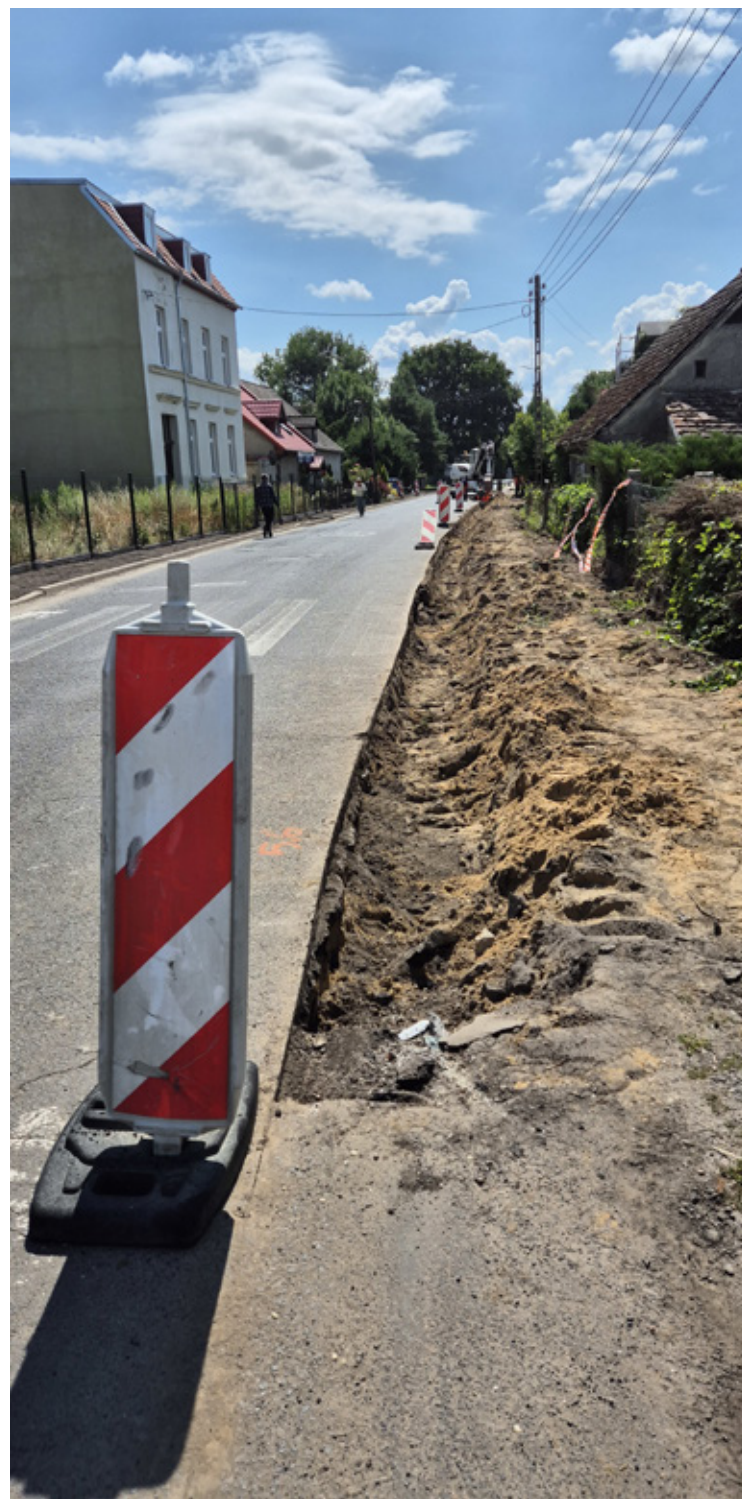
Prace remontowe na ulicy M. Willmanna w Lubiążu.
