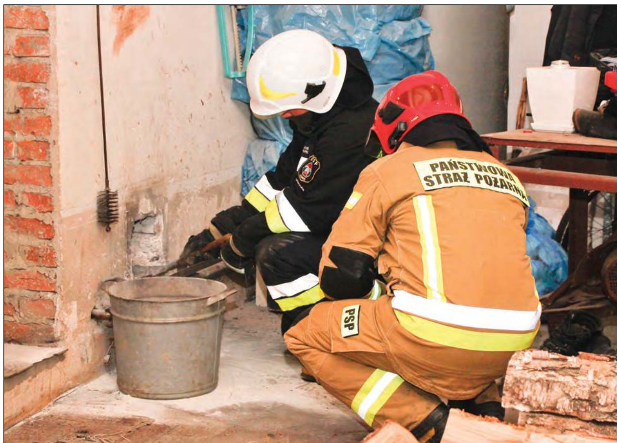
➤ Rozpoczął się okres grzewczy. Ze spalania w piecach drewna lub węgla nieustannie w kominach osadzają się sadze. Gdy pozostają w przewodach przez kilka sezonów, dym z coraz większym trudem się przez nie przedziera. W efekcie może dojść do zapłonu
