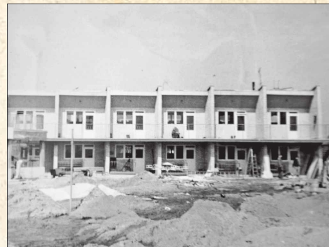
■ Budowa zakładowego domu wypoczynkowego nad morzem
