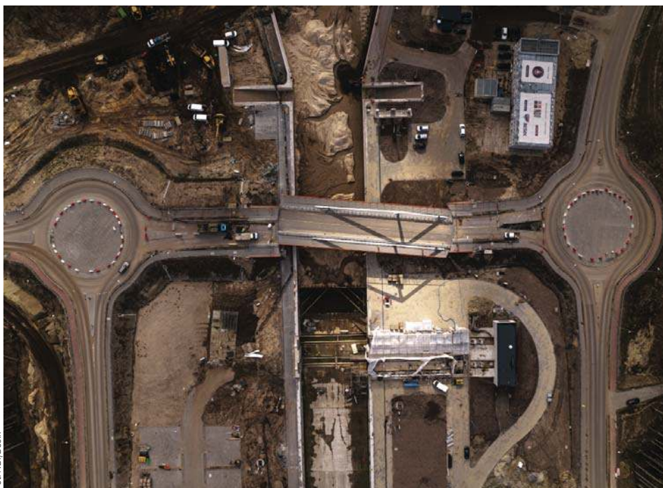
Zdjęcia z budowy przekopu Mierzei Wiślanej
