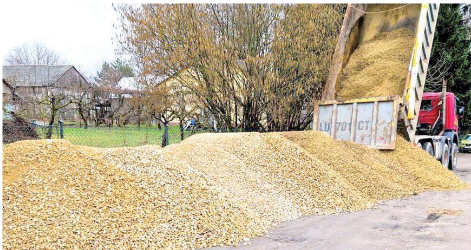
Prace ruszyły na przełomie lutego i marca
