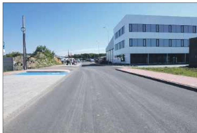
Ul. Raclawicka po remoncie.
