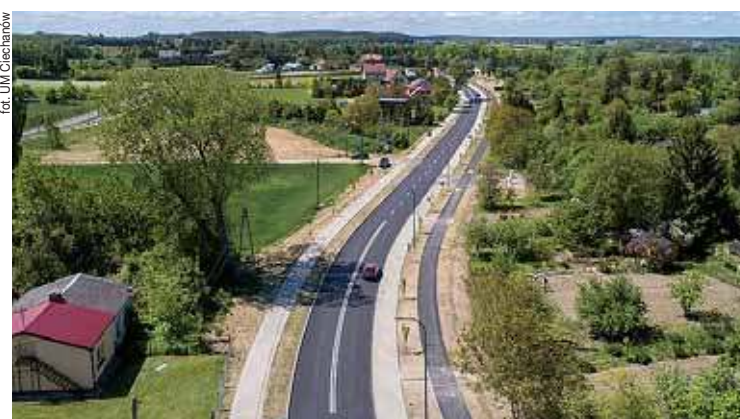
Na przebudowę ul. Leśnej w Ciechanowie samorząd Mazowsza przekazał 4 mln zł
