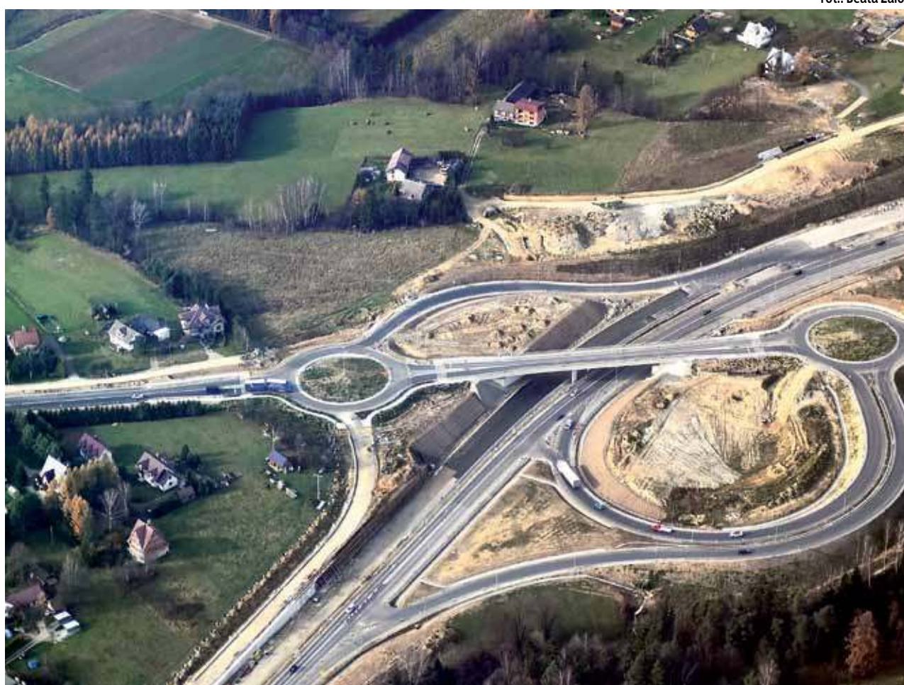
Tak z lotu ptaka wygląda w okolicach Rabki nowy Węzeł Zabornia - skrzyżowanie łączące zakopiankę z drogą krajową nr 7 na Chyżne.
