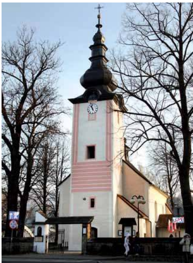
Zabytkowy kościół w Krościenku z widocznym świadkiem na wieży.
