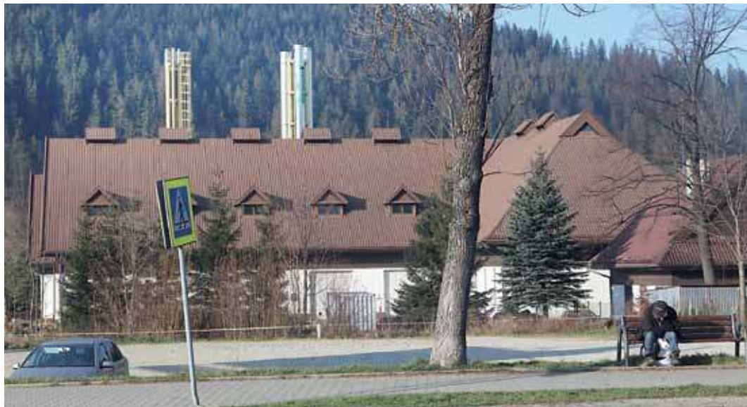
Geotermalna kotłownia w Zakopanem. Dzięki ekologicznemu ogrzewaniu w coraz większej liczbie zakopiańskich domów mamy ekologiczne źródła energii, a Geotermia Podhalańska obchodziła niedawno 25 lat.
