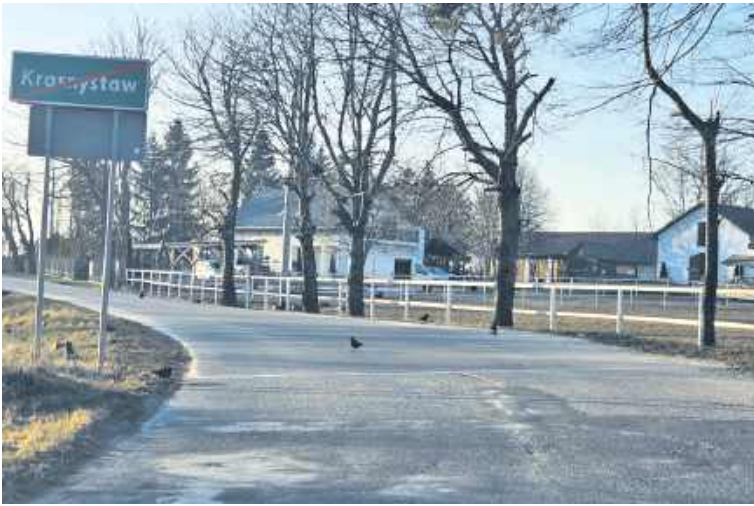
Po stronie gminy droga jest wyremontowana, po stronie miasta wciąż na niego czeka
