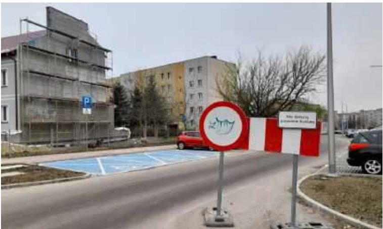
Ulica Witosza formalnie wciąż jest w przebudowie
