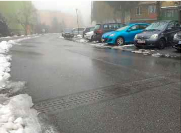
Położony bez pozwolenia i źle wyprofilowany próg już został zdemontowany. Nowego, w lepszym miejscu i prawidłowo ukształtowanego miasto kłaść nie planuje
