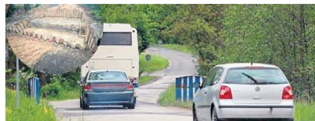
Zdezelowana Wadowicka przechodzi remont
