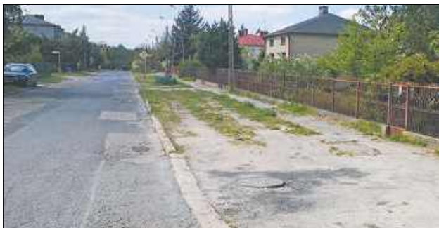
Na realizację inwestycji na ul. Twardej wykonawca ma pół roku
