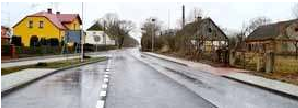
Pod koniec 2022 roku zakończyła się inwestycja polegająca na kompleksowej modernizacji infrastruktury drogowej w miejscowości Storkowo
