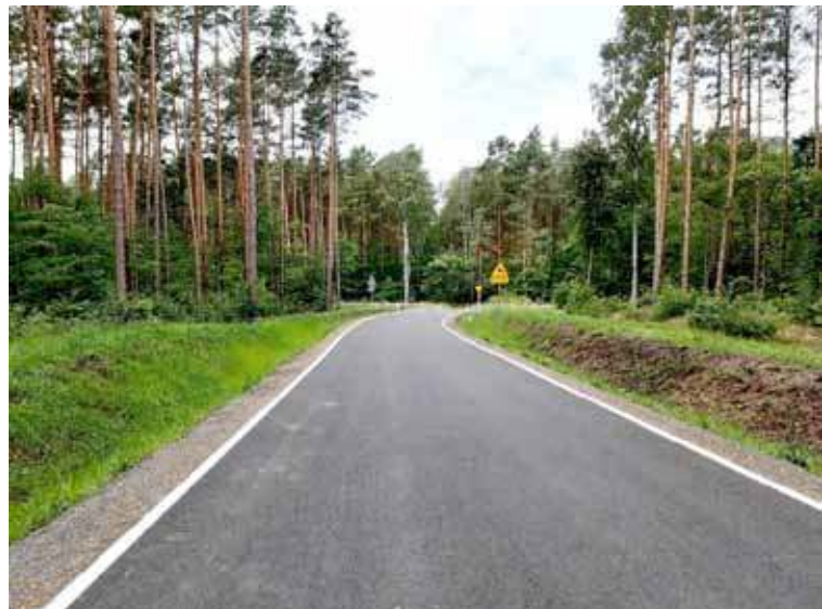
Droga Niedźwiedź-Zdunowo oddana dla kierowców pod koniec sierpnia 2020. Foto GDDKiA
