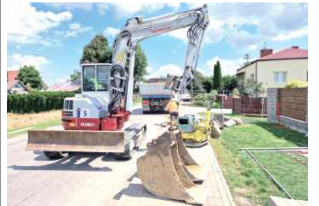
Wyliminowano elementy azbestowe, zastępując je rurami PE
