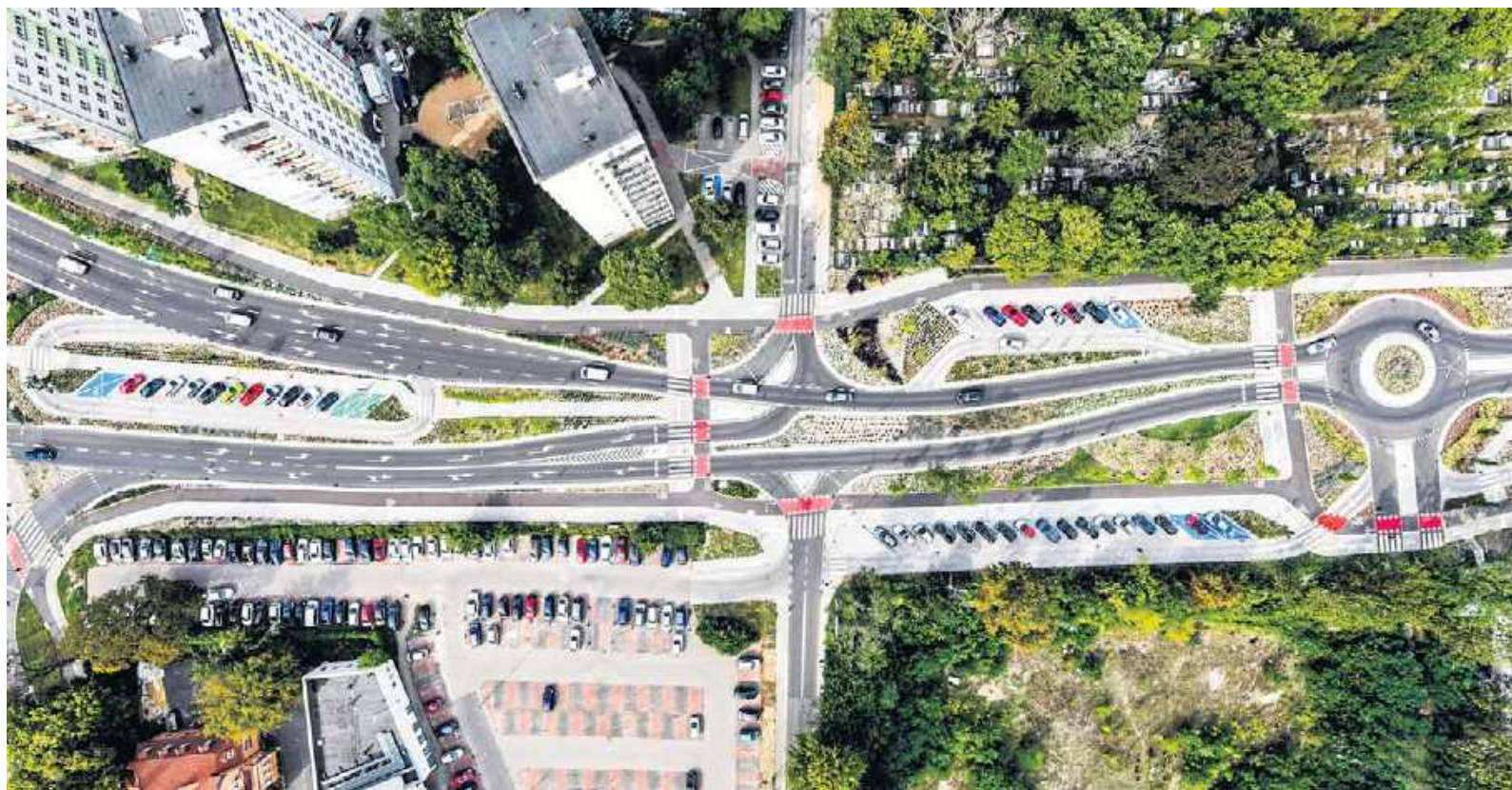
Trasa staromostowa w rejonie skrzyżowania z ulicą Gałczyńskiego oraz w sąsiedztwie cmentarza św. Jerzego i Osiedla Młodych
