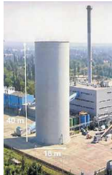
Tak wyglądać ma akumulator ciepła przy OPEC-u
