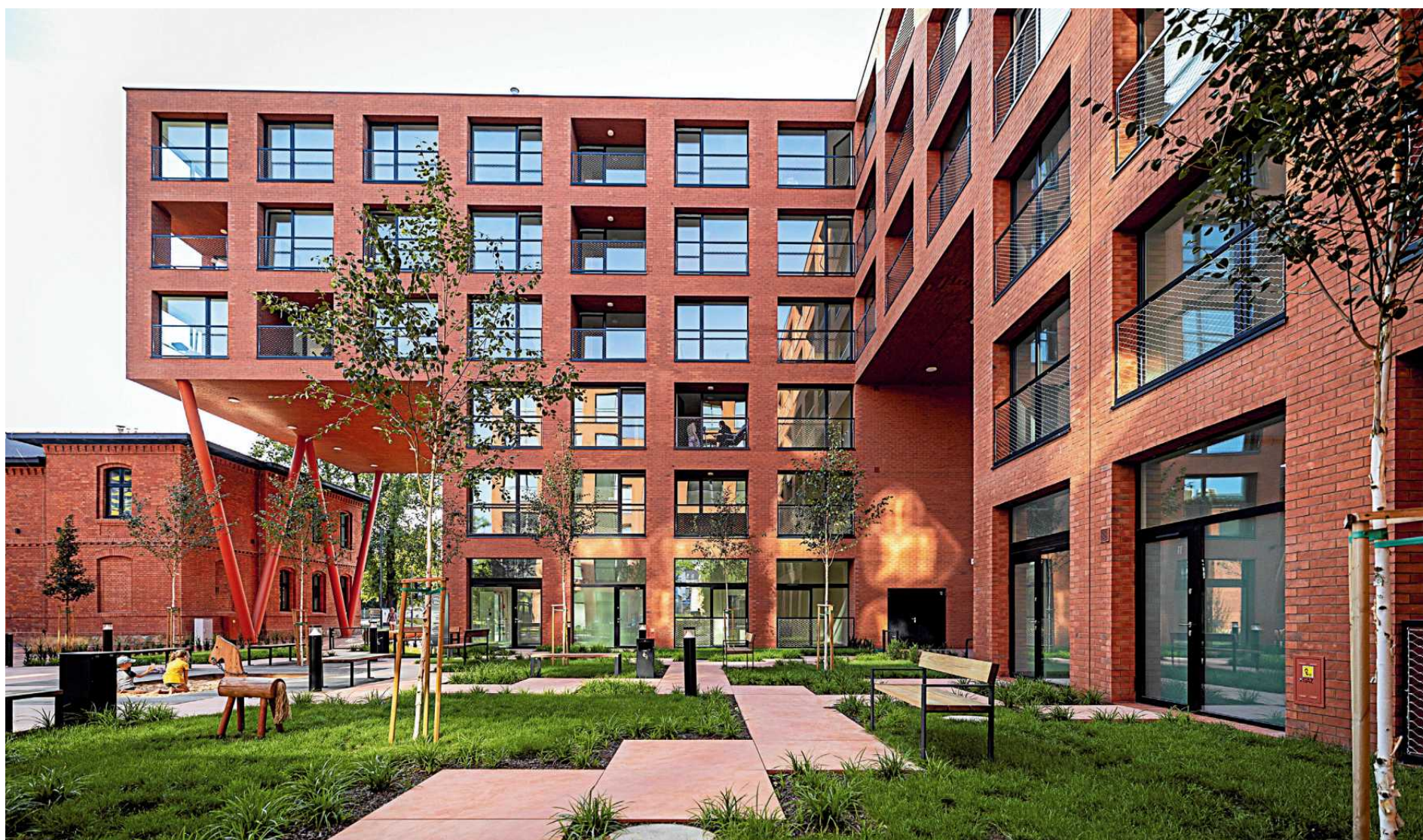
• TBS-owski kompleks mieszkalny „Ajnfart” w centrum Rybnika. Na dziedzińcu są ławki i siedziska do odpoczynku i nieformalnych spotkań z sąsiadami. A przejścia przez budynek (tzw. ajnfarty) są szerokie, zadaszone, mogą być wykorzystywane na wspólne posiłki czy zabawy dzieci FOT. GRZEGORZ CELEJEWSKI / AGENCJA WYBORCZA.PL
