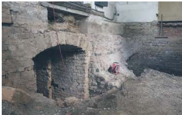
Zakrystia północna w bazylice pw. Narodzenia NMP, odsłonięte przejście do krypt pod prezbiterium i nawą główną.
