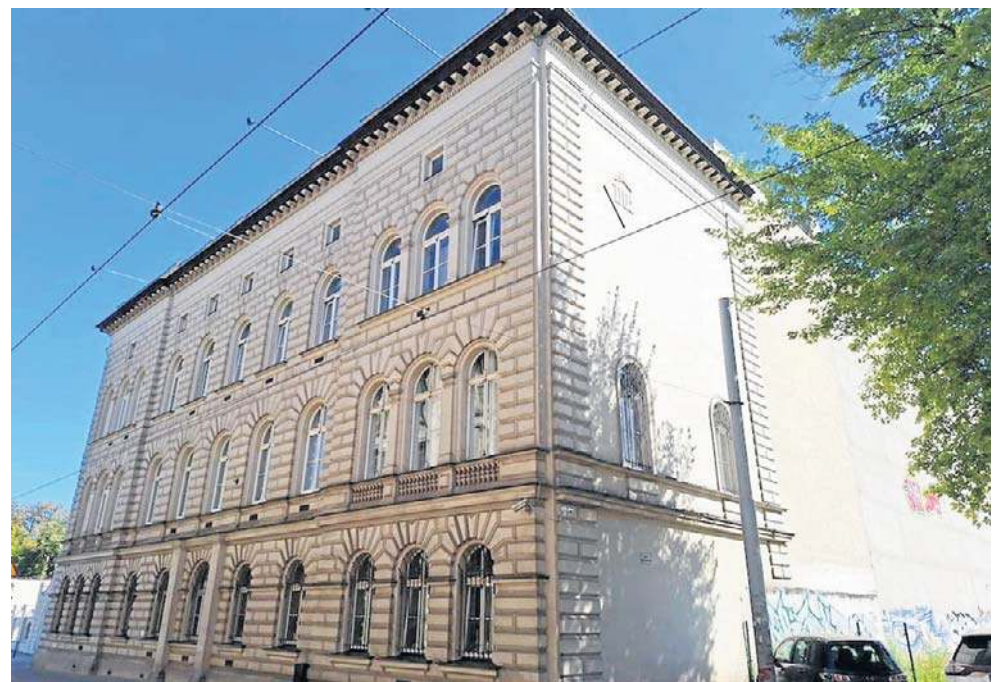
Po gruntownym remoncie pałac Roberta Biedermanna odzyskał dawną świetność.
