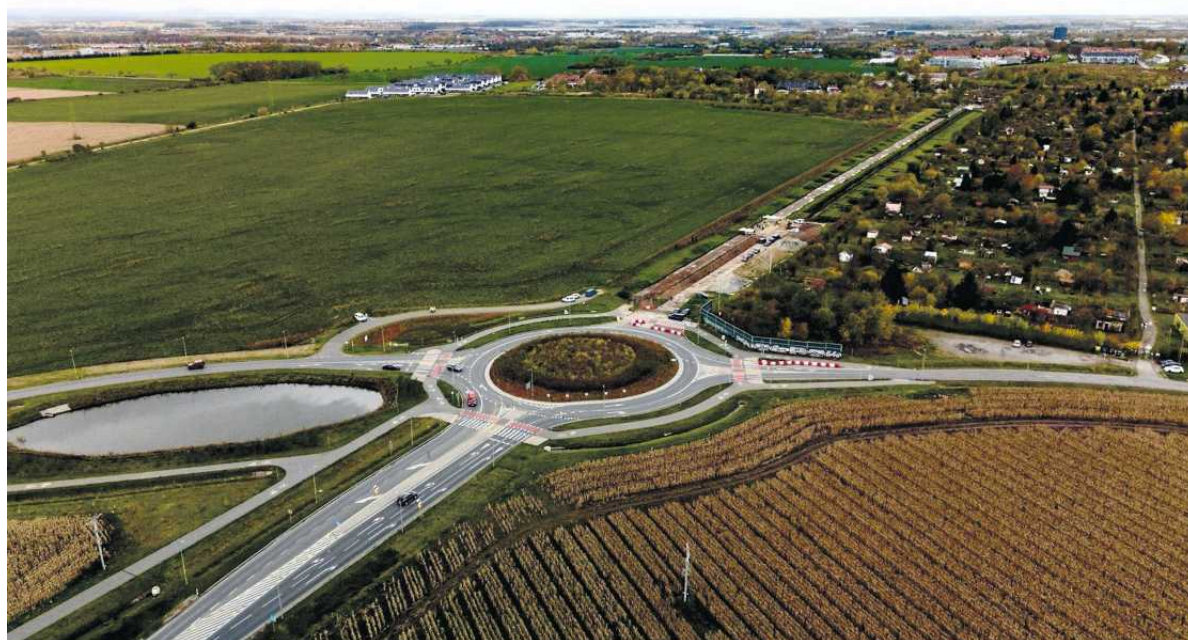
• Zakończenie budowy Wschodniej Obwodnicy Wrocławia zaplanowano na 2028 rok FOT. MATERIAŁY PRASOWE
