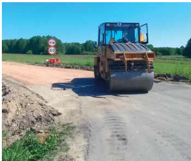
Przebudowa drogi powiatowej Garbatówka-Kopina
