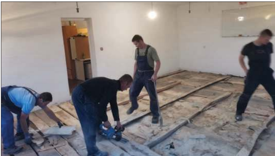
➤ Druhowie wiele czasu poświęcili na przeprowadzenie remontu. Większość prac wykonali sami w czynie społecznym
