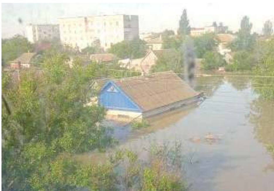
Dom przyjaciółki Marka Patryna z Gołej Przystani znalazł się pod wodą. Zdjęcie z 8 czerwca
