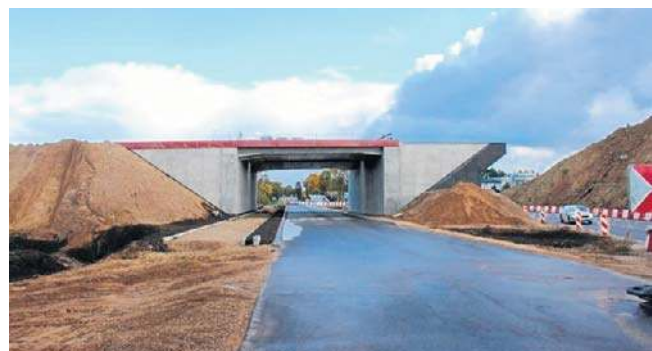
FOT. GDDKiA/STRONA KONTRAKTU
