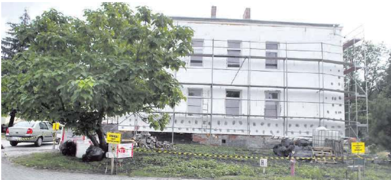
Budynek oddziału zakaźnego przechodzi gruntowny remont.
