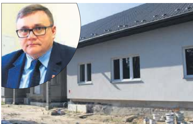
Gmina Nielisz podjęła skuteczne działania w kierunku poprawy życia i opieki nad osobami niepełnosprawnymi. Adam Wal: – Prace budowlane przebiegają zgodnie z założeniami.
