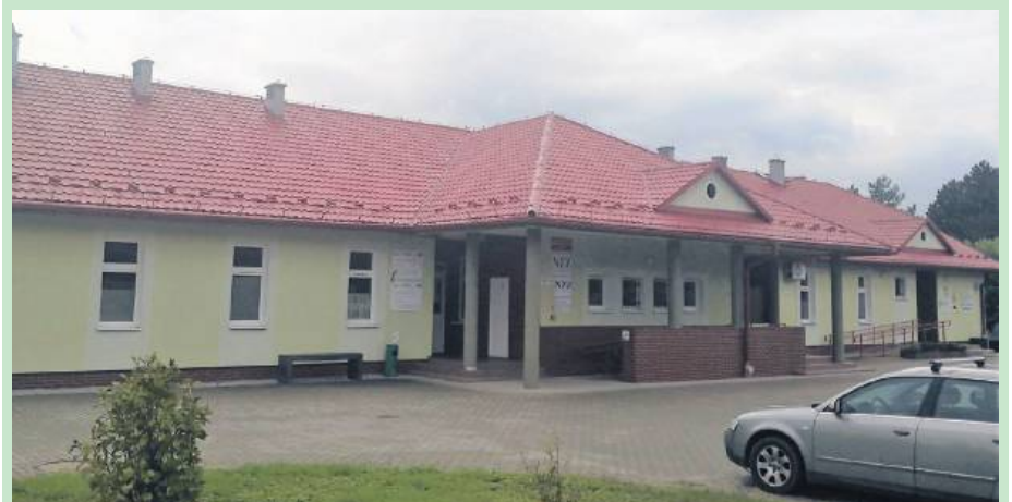
Jeszcze w październiku w Ośrodku Zdrowia w Prusach zostanie zamontowana pompa ciepła, a na dachu budynku instalacja fotowoltaiczna o mocy 20 KW
