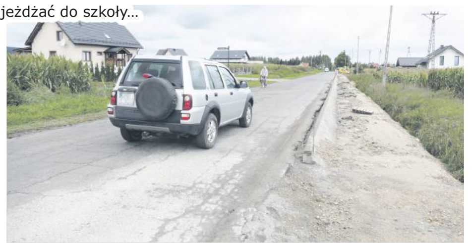
Obecnie przy ul. Ziębickiej jest budowany chodnik. Gdy zostanie już zrobiony, gmina ma kupić tablicę informującą o przystanku autobusu szkolnego, która będzie zamontowana przy skrzyżowaniu ulic Spokojnej i Ziębickiej
