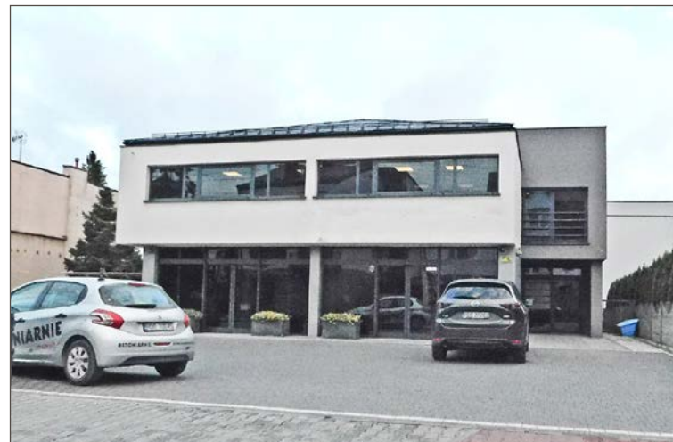
Na razie Filia nr 4 MiPBP przeniesiona została do tego budynku.
