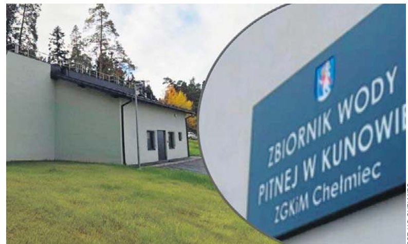
Dobiegły końca prace związane z budową zbiornika wody pitnej oraz całą infrastrukturą towarzyszącą na terenie gminy Chełmec
