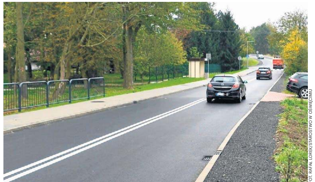
Wiele lat czekano na modernizację odcinka drogi powiatowej w Porębie Wielkiej
