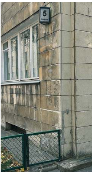
Fot. Biuro Stołecznego Konserwatora Zabytków
