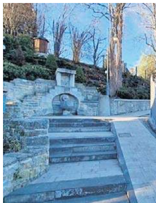
Trakt świętej Kingi gotowy po remoncie
